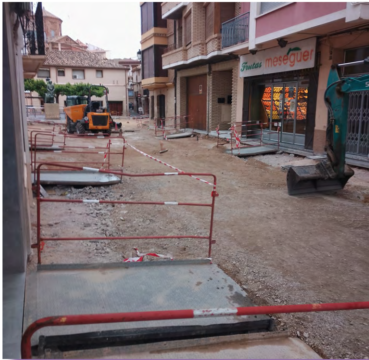
Obras remodelación Calle y Plaza San Miguel
